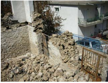
Φωτ. 13, 14: Κατάρρευση τμήματος του κτηρίου
