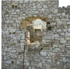
Φωτ. 5, 6: Καύση ξύλινων υπερθύρων. Εν συνεχεία κατάρρευση υπερκείμενου τόξου ή υπερκείμενης τοιχοποιίας
