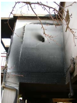
Φωτ. 19: Αποκόλληση τοίχων πληρώσεως από τα στοιχεία του φέροντος οργανισμού
