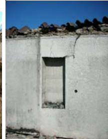
Φωτ. 7, 8: Ρηγματώση υπερθύρων (από τοιχοποιία)
