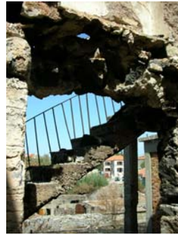
Φωτ. 13, 14: Κατάρρευση τμήματος του κτηρίου
