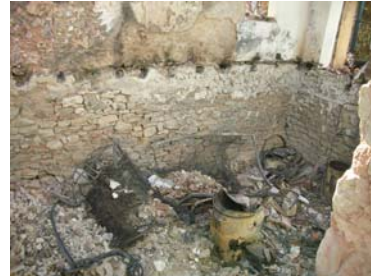
Φωτ. 4: Καύση και κατάρρευση ξύλινων πατωμάτων
