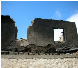
Φωτ. 5, 6: Καύση ξύλινων υπερθύρων. Εν συνεχεία κατάρρευση υπερκείμενου τόξου ή υπερκείμενης τοιχοποιίας
