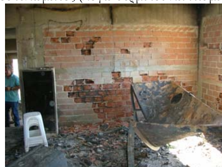
Φωτ. 20: Αποφλοΐωση τοίχων πληρώσεως σε περιοχές με μεγάλη ποσότητα καύσιμης ύλης
