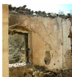
Φωτ. 7, 8: Ρηγματώση υπερθύρων (από τοιχοποιία)
