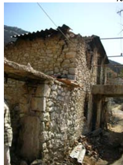
Φωτ. 11, 12: Κατακόρυφες ρωγμές στην σύνδεση εγκάρσιων τοίχων
