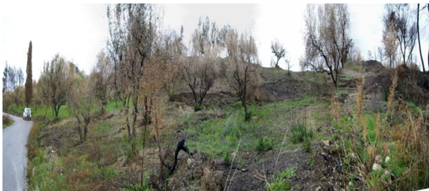
Εικόνα 3. Γενική άποψη της ζώνης αστοχιών στη θέση Ασίκελος.
