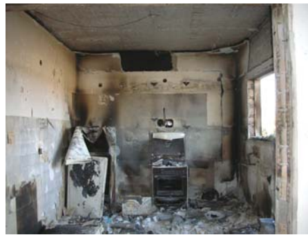
Εικόνα 2: Κτήριο στην Μιράκα: (α) Αποθηκευτικός χώρος στην πιλοτή, (β) Δοχεία ελαιολάδου μέσα στον αποθηκευτικό χώρο, (γ) Κατάσταση στον υπερκείμενο όροφο.
