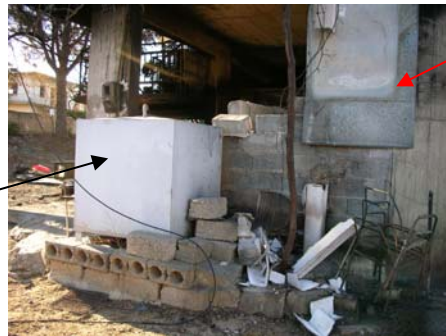
Εικόνα 3: Κτήριο στην Μιράκα: Δοχείο πετρελαίου θέρμανσης σε μικρή απόσταση από την αποθήκη ελαιολάδου
