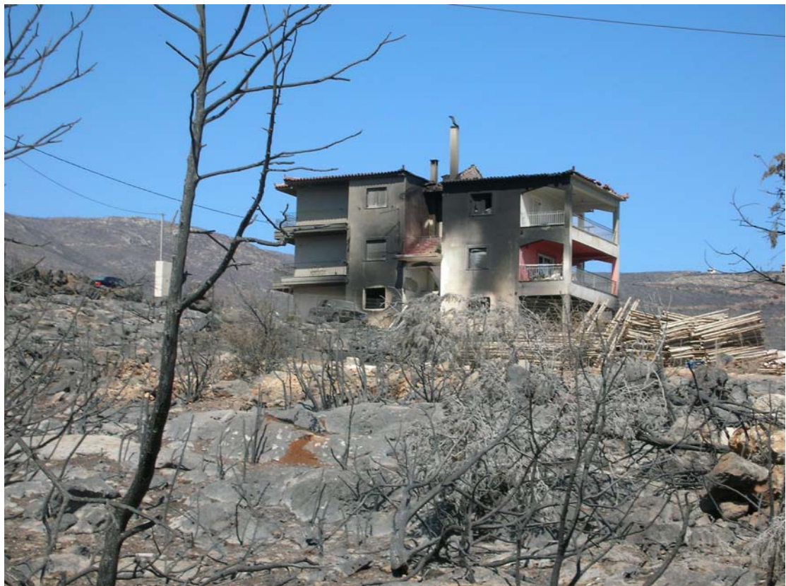
ΕΙΚΟΝΑ 2: ΚΤΗΡΙΟ ΣΤΟΝ ΟΙΚΙΣΜΟ ΤΗΣ ΑΚΤΗΣ ΝΗΡΕΑ ΚΑΙ ΕΛΕΥΘΕΡΟΙ ΧΩΡΟΙ ΜΕΤΑ ΑΠΟ ΤΗΝ ΠΥΡΚΑΓΙΑ
