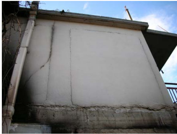
ΕΙΚΟΝΑ 17: ΑΠΟΚΟΛΛΗΣΗ ΤΟΙΧΩΝ ΠΛΗΡΩΣΕΩΣ-ΦΕΡΟΝΤΟΣ ΟΡΓΑΝΙΣΜΟΥ
