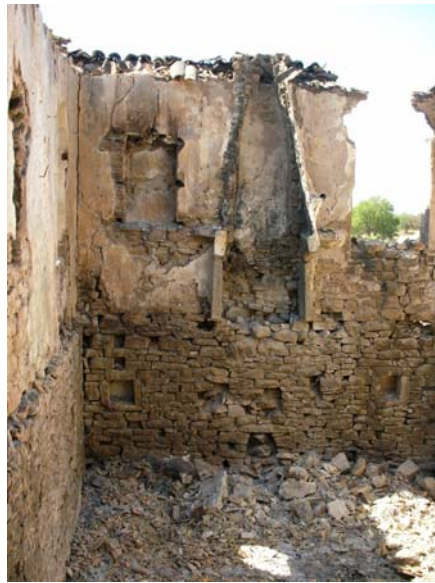
ΕΙΚΟΝΑ 5: ΚΑΥΣΗ ΞΥΛΙΝΟΥ ΥΠΕΡΘΥΡΟΥ, ΚΑΤΑΡΡΕΥΣΗ ΥΠΕΡΚΕΙΜΕΝΟΥ ΤΟΞΩΤΟΥ ΛΙΘΙΝΟΥ ΥΠΕΡΘΥΡΟΥ
