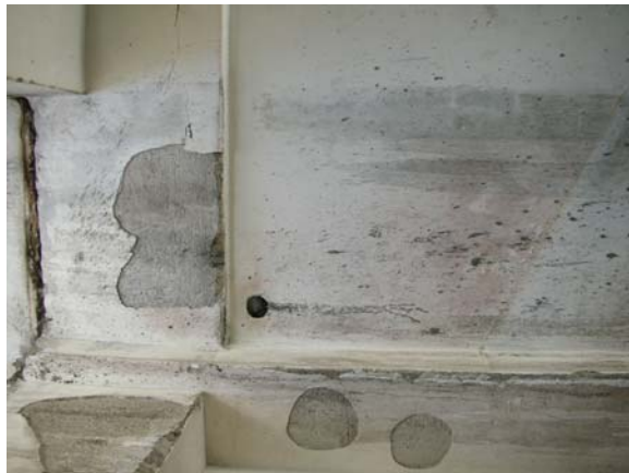
ΕΙΚΟΝΑ 15: ΑΠΟΚΟΛΛΗΣΗ ΚΑΙ ΠΤΩΣΗ ΕΠΙΧΡΙΣΜΑΤΟΣ-ΑΛΛΑΓΗ ΧΡΩΜΑΤΟΣ
