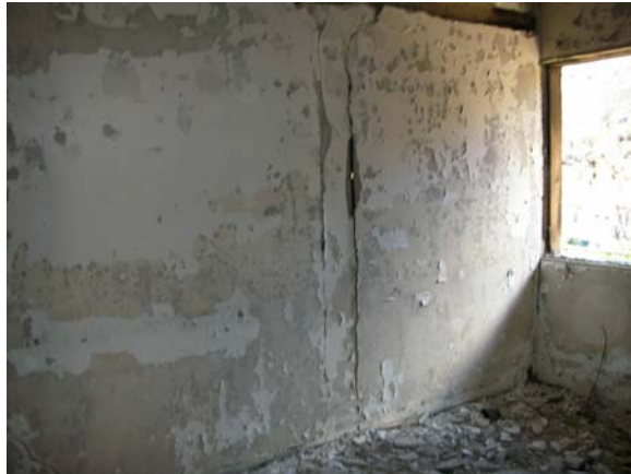
ΕΙΚΟΝΑ 12: ΑΠΟΚΟΛΛΗΣΗ ΤΟΙΧΩΝ ΠΛΗΡΩΣΕΩΣ ΚΑΙ ΦΕΡΟΝΤΟΣ ΟΡΓΑΝΙΣΜΟΥ
