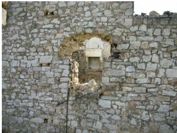
ΕΙΚΟΝΑ 9: ΚΑΥΣΗ ΞΥΛΙΝΟΥ ΥΠΕΡΘΥΡΟΥ-ΚΑΤΑΡΡΕΥΣΗ ΥΠΕΡΚΕΙΜΕΝΟΥ ΤΟΞΟΥ
