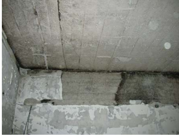
ΕΙΚΟΝΑ 13: ΑΠΟΚΟΛΛΗΣΗ ΚΑΙ ΠΤΩΣΗ ΕΠΙΧΡΙΣΜΑΤΩΝ
